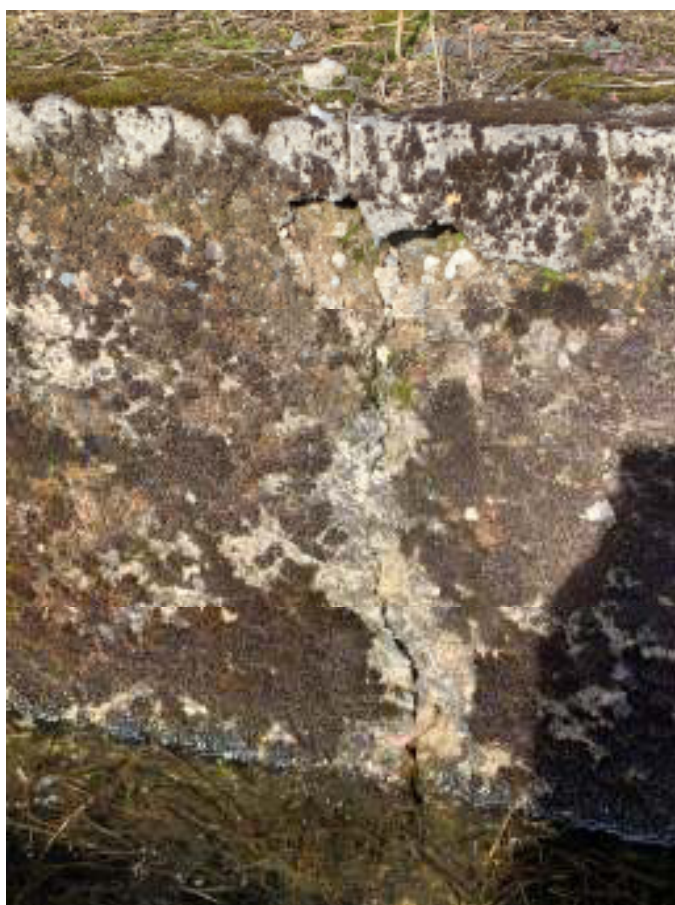
Foto č. 11 – svislá trhlina
