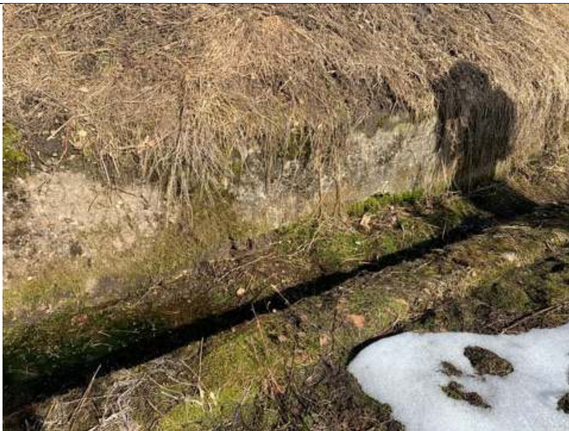
Foto č. 9 – kaverny, degradovaná vrchní vrstva
