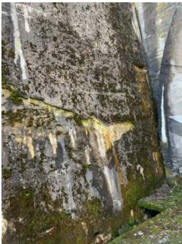
Foto č. 12 – výluhy, plošné odtrhy degradované vrstvy betonu
