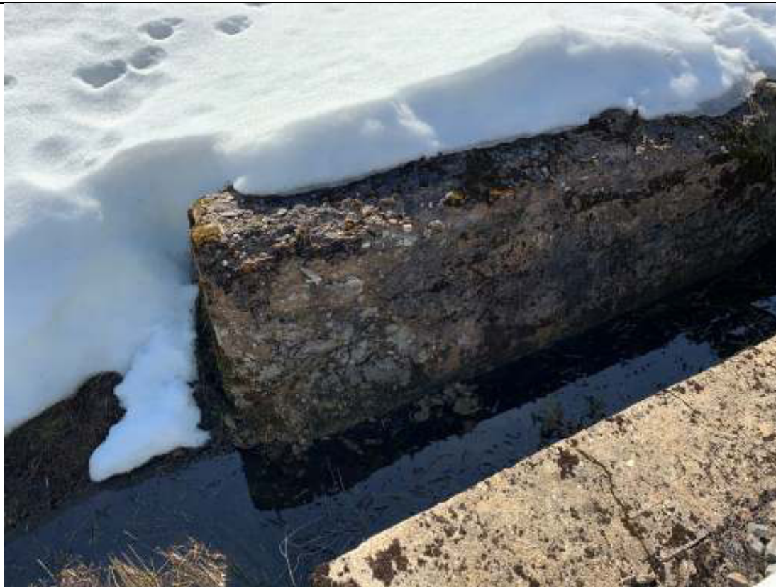
Foto č. 20 – plošná degradace
